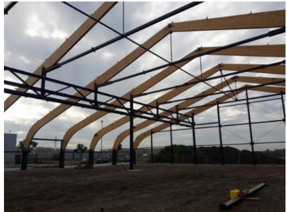
Figuur 3.17: De stalen staanders ter ondersteuning van de houten spanten (Circulaire bouweconomie)
