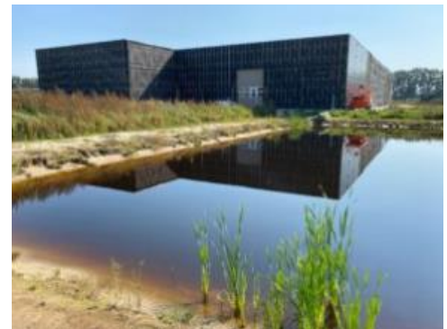
Figuur 3.29: Uitgegraven vijver t.b.v. de stroomvoorziening (Dijkhuis bouwteam van waarde, z.d.)
