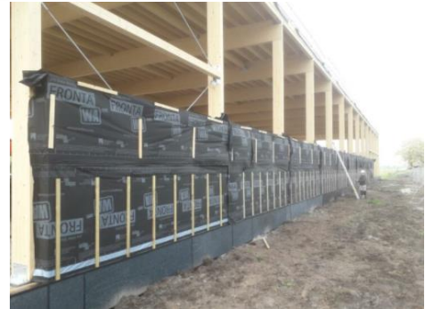
Figuur 3.30: Cellulose isolatie in de houten geveldelen (Dijkhuis bouwteam van waarde, z.d.)
