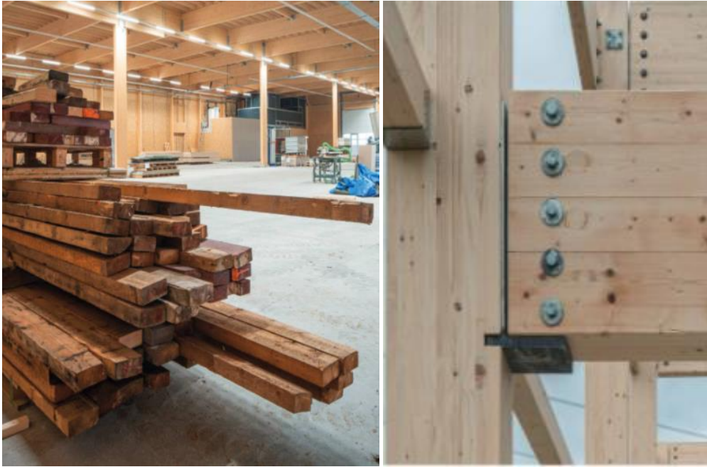
Figuur 3.33 bedrijfshal RPP (Industriebouw, 2020.)
