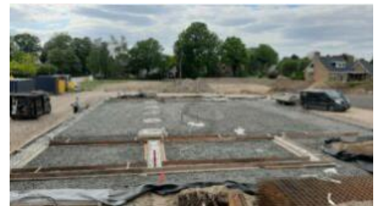
Figuur 3.7: glasgranulaat in de vloerisolatie (Dijkhuis bouwteam van waarde)
