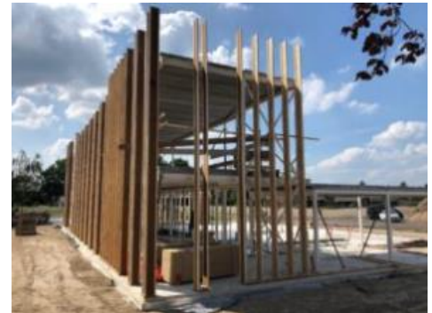
Figuur 3.6: houten gevel apotheek (Dijkhuis bouwteam van waarde, z.d.)
