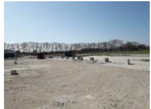
Figuur 3.28: De betonfundatie met co 2 arm cement. (Dijkhuis bouwteam van waarde, z.d.)
