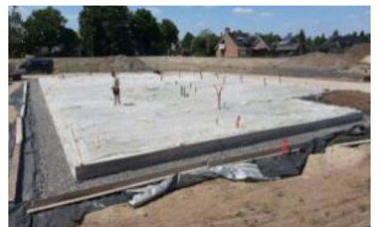
Figuur 3.8: Betonvloer Apotheek (Dijkhuis bouwteam van waarde, z.d.)
