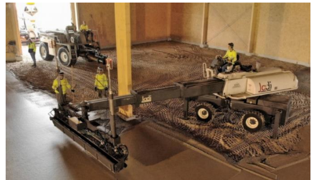
Figuur 3.31: Vloer bedrijfshal RPP Kunststoffen (RPP kunststofoplossingen)
