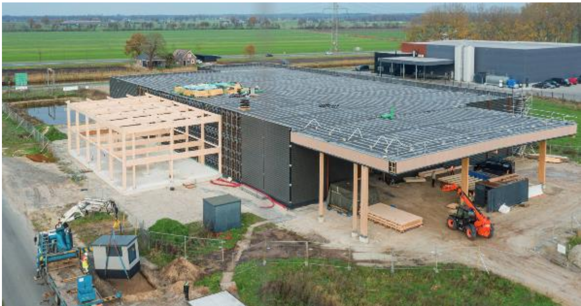
Figuur 3.27: Realisatie bedrijfshal RPP (Industriebouw online, 2020)
